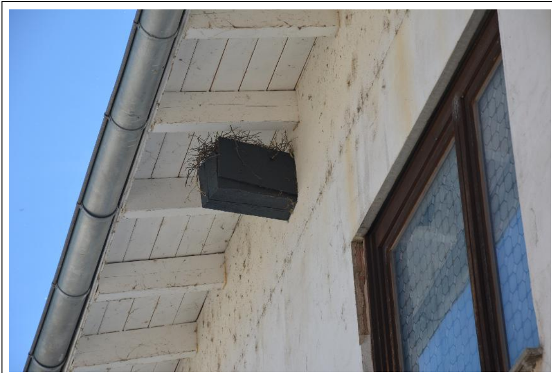
Abbildung 11: Altnest auf Balken unter Dachüberstand
