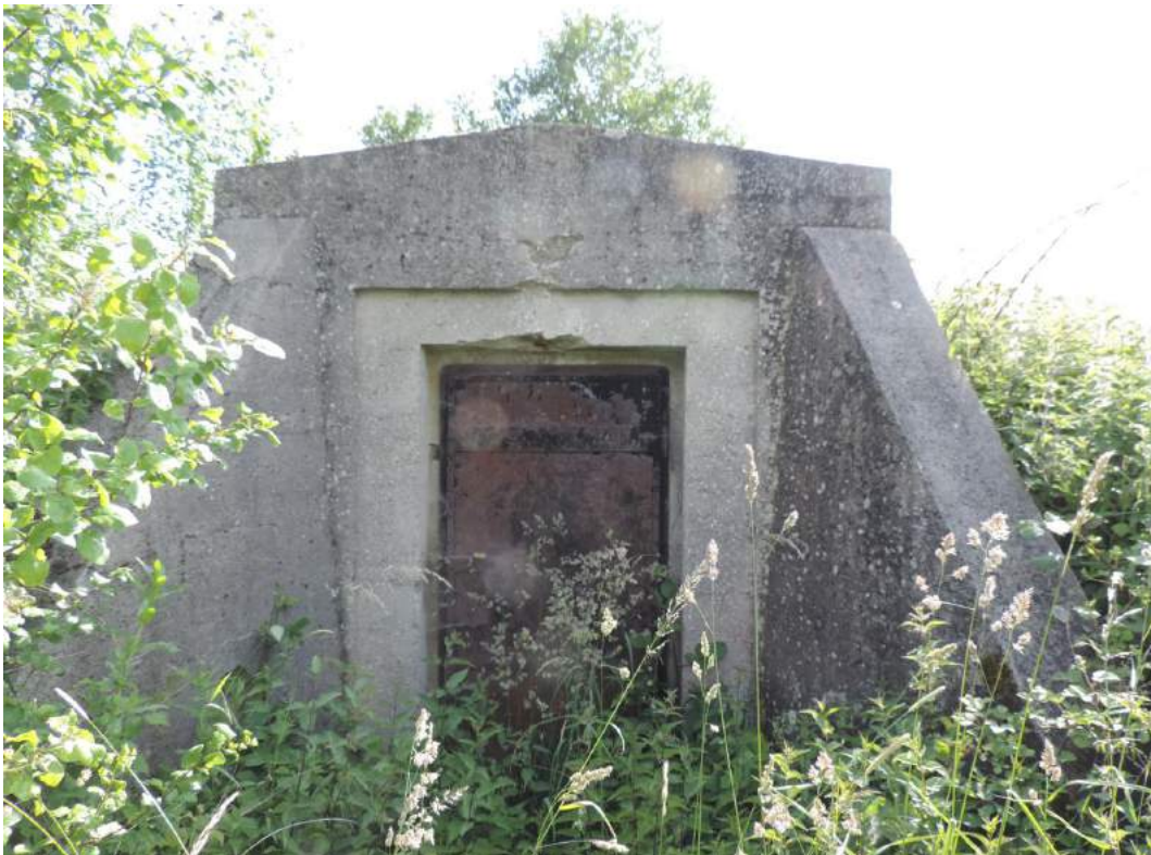
Bild 10: Wasserhäuschen außerhalb des Plangebiets
