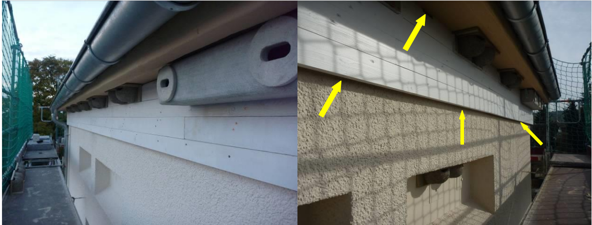
Abb. 44+45: Finaler Zustand, die Pfeile zeigen die Ein- bzw. Ausflugmöglichkeiten an, hier an einem ehemaligen Trafoturm mit weiteren Maßnahmen für Mehlschwalben und Mauersegler.
