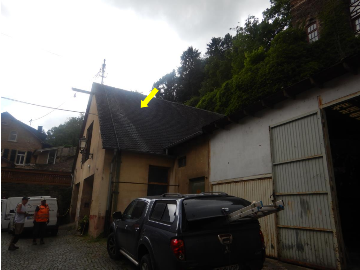
Abb. 33: Blick vom Innenhof auf eines der beiden Ersatzgebäude.
