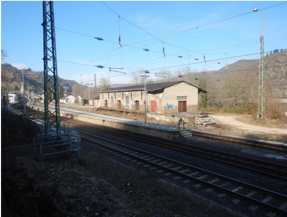
Abb. 2: Blick von SW-NO ins Plangebiet.
