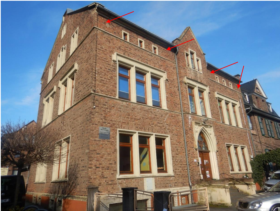
Abb. 47: Die Pfeile zeigen die Anbringungsorte der Ersatzmaßnahmen im Bereich Trauf, hier auf der Südseite des Gebäudes.
