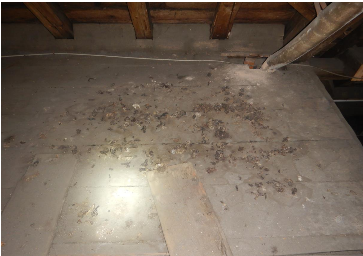
Abb. 39: Marderkot. Zur Vergrämung des Steinmarders muss der Dachstuhl bzw. die Zugänge verschlossen werden.
