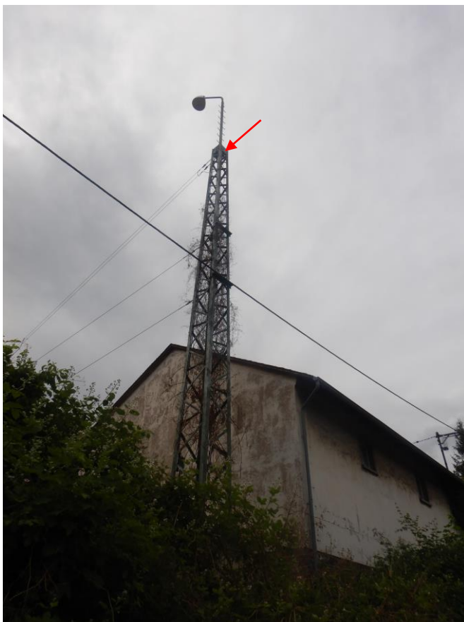
Abb. 14: Mast mit Brutplatz (Pfeil) des Haussperlings
