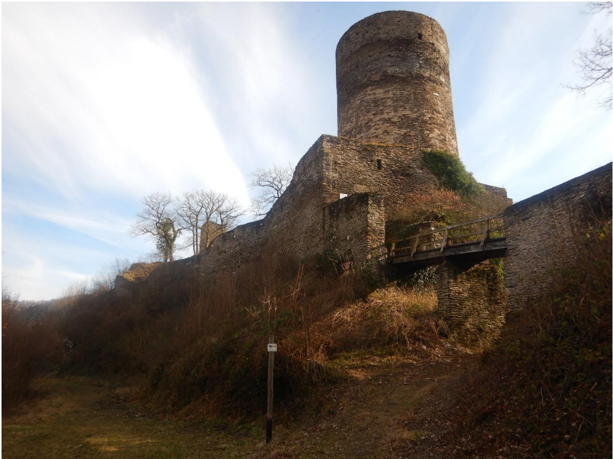
Abb. 19: Burgruine Stahlberg in deren Umfeld die Aufwertungsmaßnahmen bzw. Ersatzlebensstätten für den betroffenen Individuenanteil der Mauereidechsen hergestellt werden sollen.
