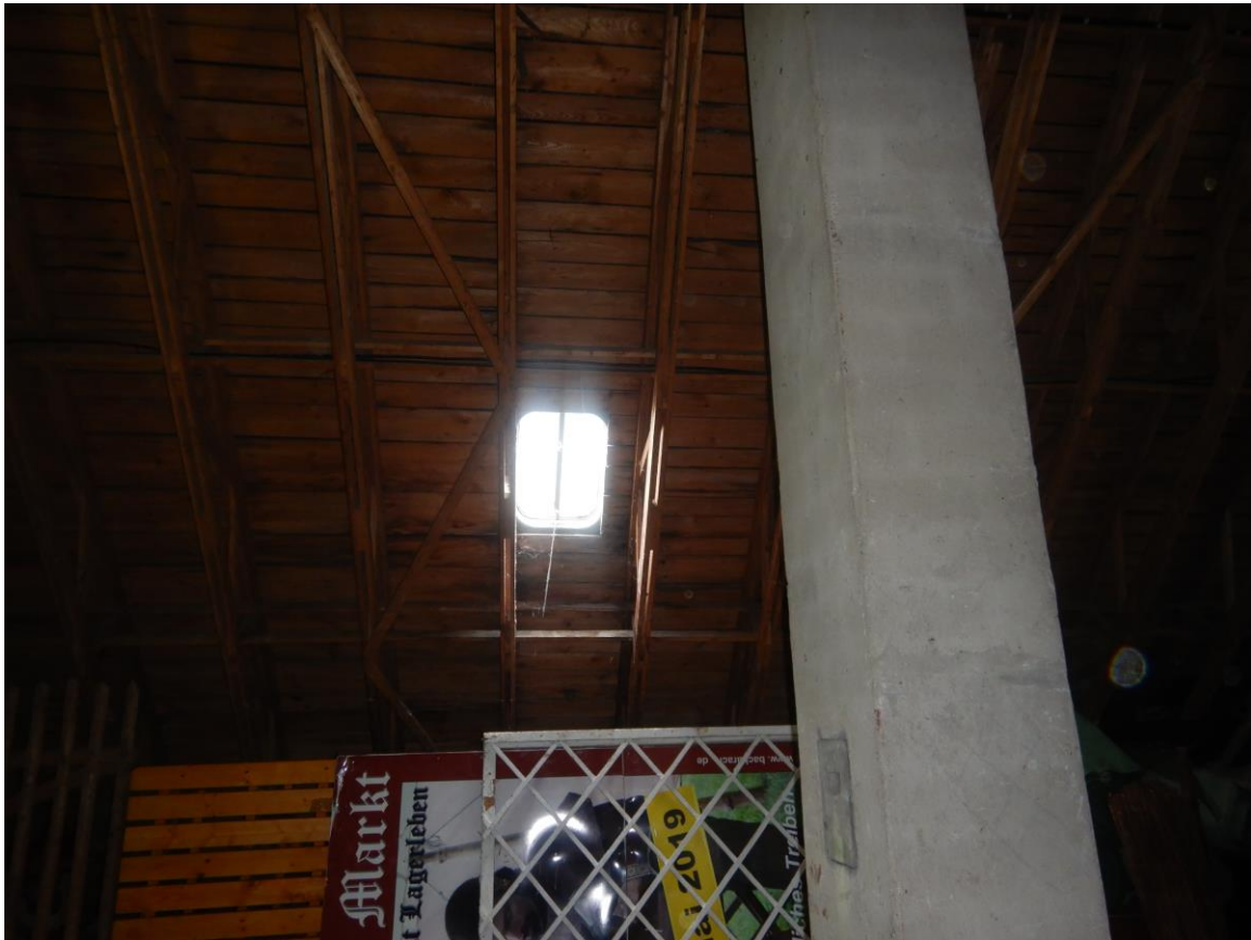
Abb. 34: Die Dachflächenfenster müssen, z.B. mit schwarzer Teichfolie, abgedunkelt werden.
