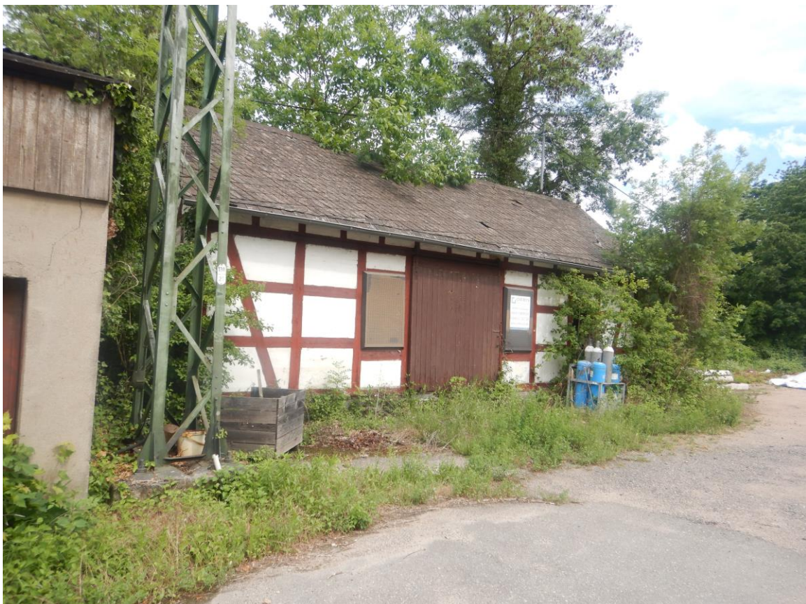
Abb. 7: Die Abbruchgebäude (Bahnhof und Hallen/Schuppen) finden sich im westlichen Teil des Plangebietes.
