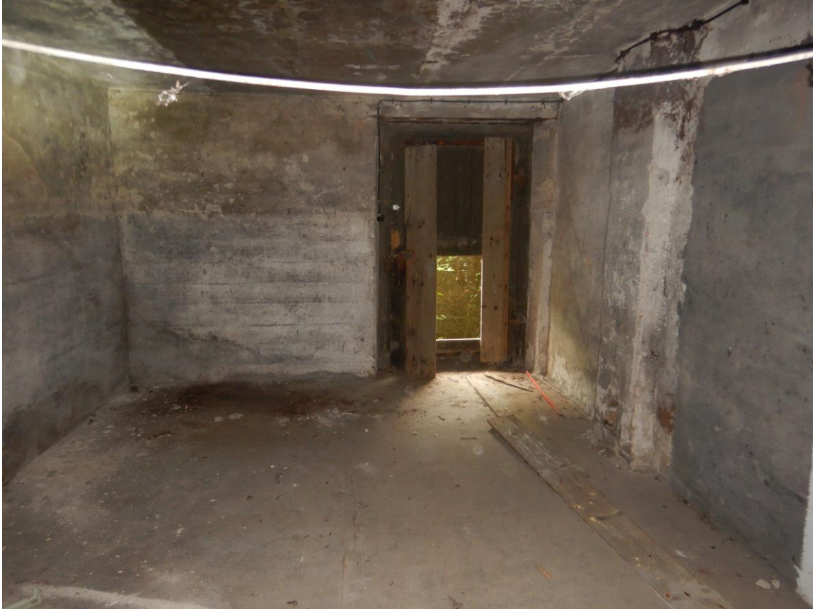
Abb. 52: Kellergewölbe fanden sich an zwei der Abbruchgebäude, jedoch ohne Nachweis oder Hinweise auf eine Besiedlung durch Fledermäuse oder Amphibien.
